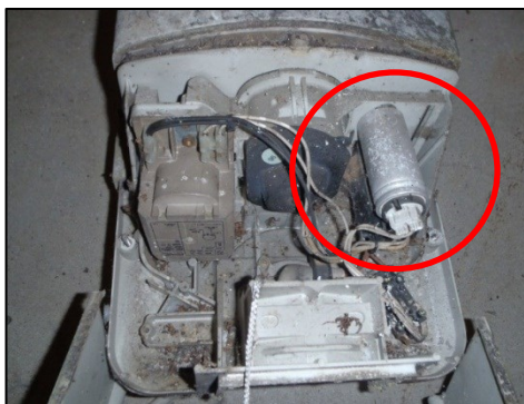
Eksempler på placering af kondensatorerne i lysstofarmaturer (øverst) og armaturer til kviksløvdamp-lamper og natriumlamper (nederst).
